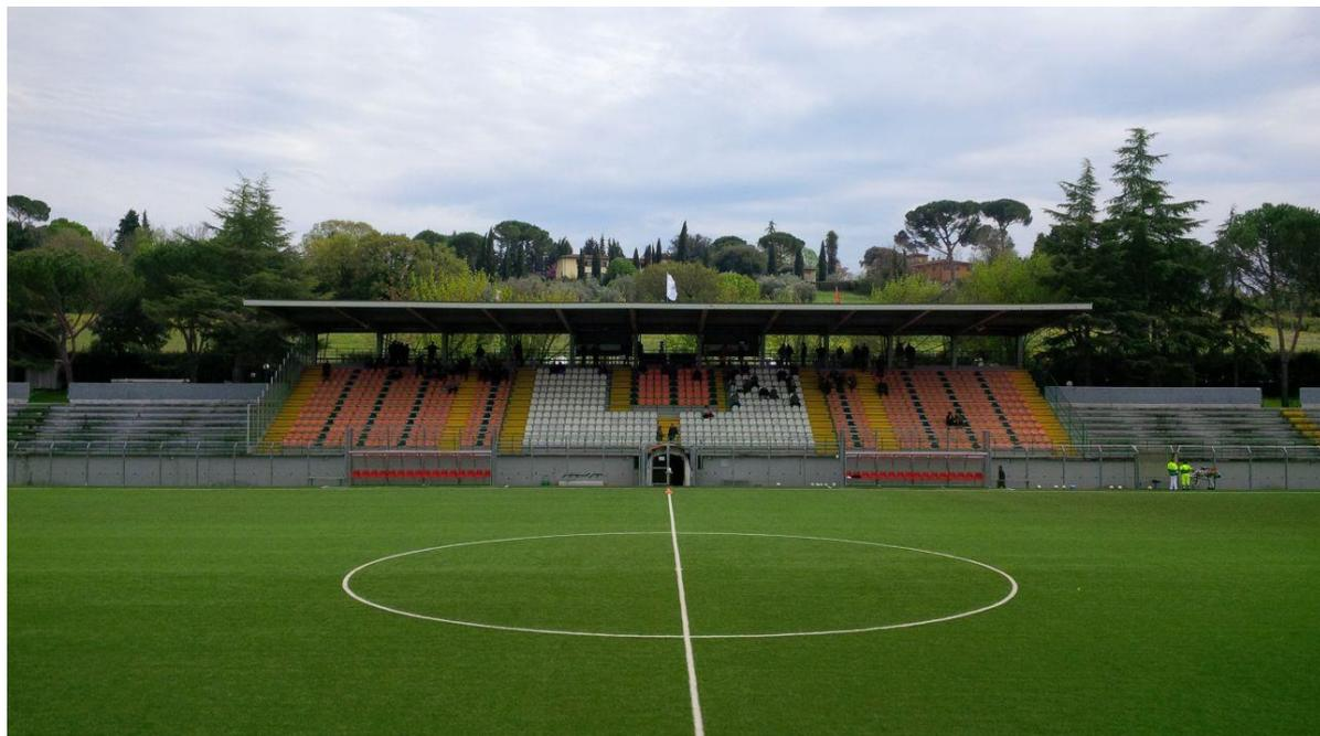
Il campo centrale in erba sintetica è stato realizzato da Limonta Sport con il sistema MAX S con intaso prestazionale GEO PLUS, 100% naturale di origine vegetale. Questo manto, realizzato con filati dalla speciale sezione a ritorno di memoria, in combinazione con GEO PLUS, rappresenta l'avanguardia nel panorama dei tappeti sintetici per il gioco del calcio a livello professionistico.
